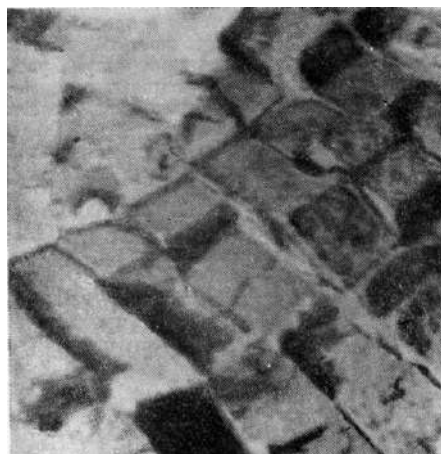
Рис. 1. Характер разрушения свода из кессонного кирпича (снимок повернут на 180°)
