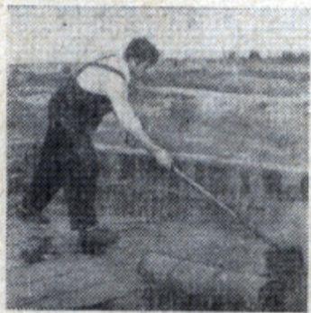
Бригадир В. Измаилов на кровельных работах (стройотряд «Канск-79»).
