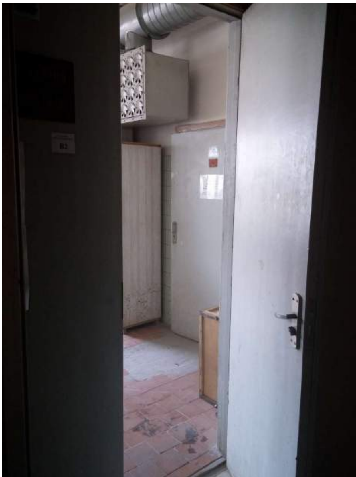
Рисунок 65 – Помещение № 307 для профилактического обслуживания учебного оборудования для обучающихся по направлению подготовки 29.03.04 Технология художественной обработки материалов (уровень бакалавриата)
