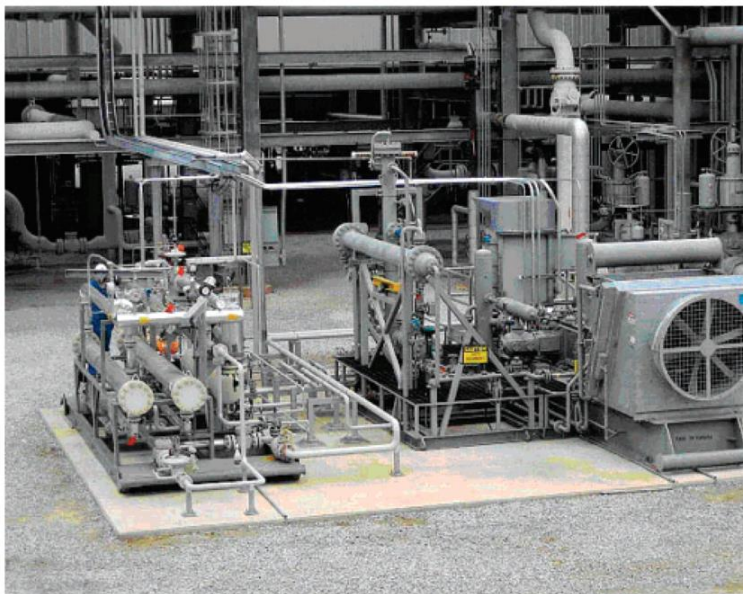
Рисунок 14. Фотография двухстадийного мембранного аппарата для выделения C_{3+} углеводородов из потока природного газа.
