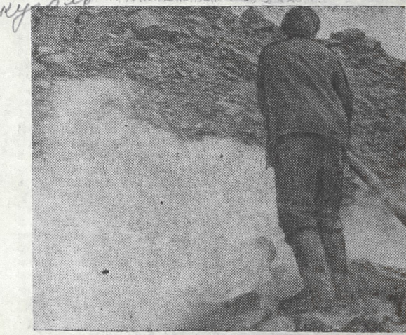
Тушение горящих отвалов на разрезе «Черногогорский»
