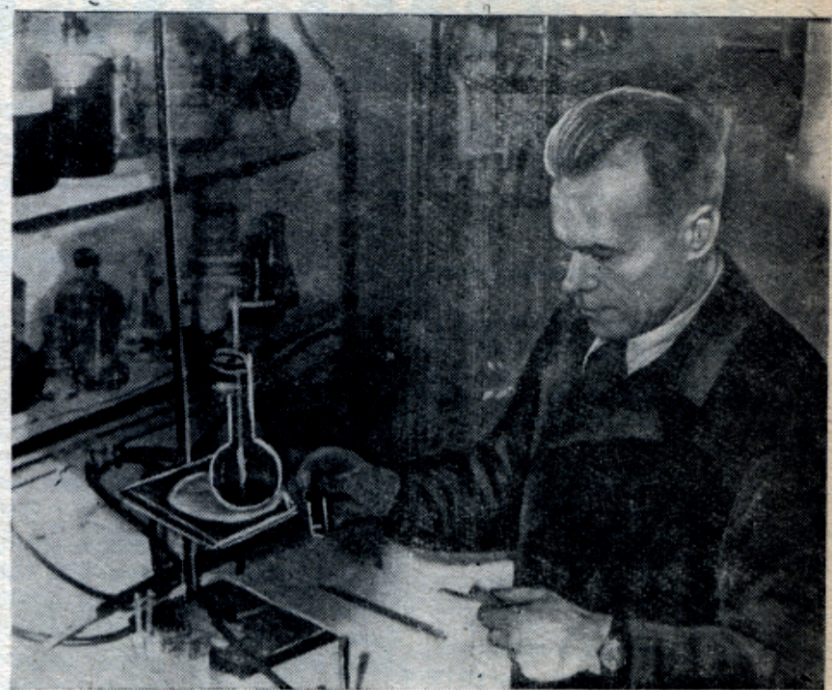
На кафедре пластических масс ведутся работы по получению и применению в промышленности новых термостойких синтетических смол. Это позволяет использовать пластические массы в условиях высоких температур. На снимке: научный сотрудник кафедры В. И. Итинский испытывает на газовой горелке горючесть новых пластмасс.
