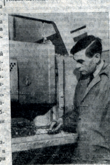
Лаборант кафедры технологии стекла А. Добронадежин наблюдает за процессом спекания пеностекла.
